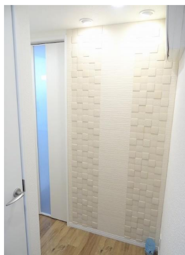
玄関エコカラット設置
